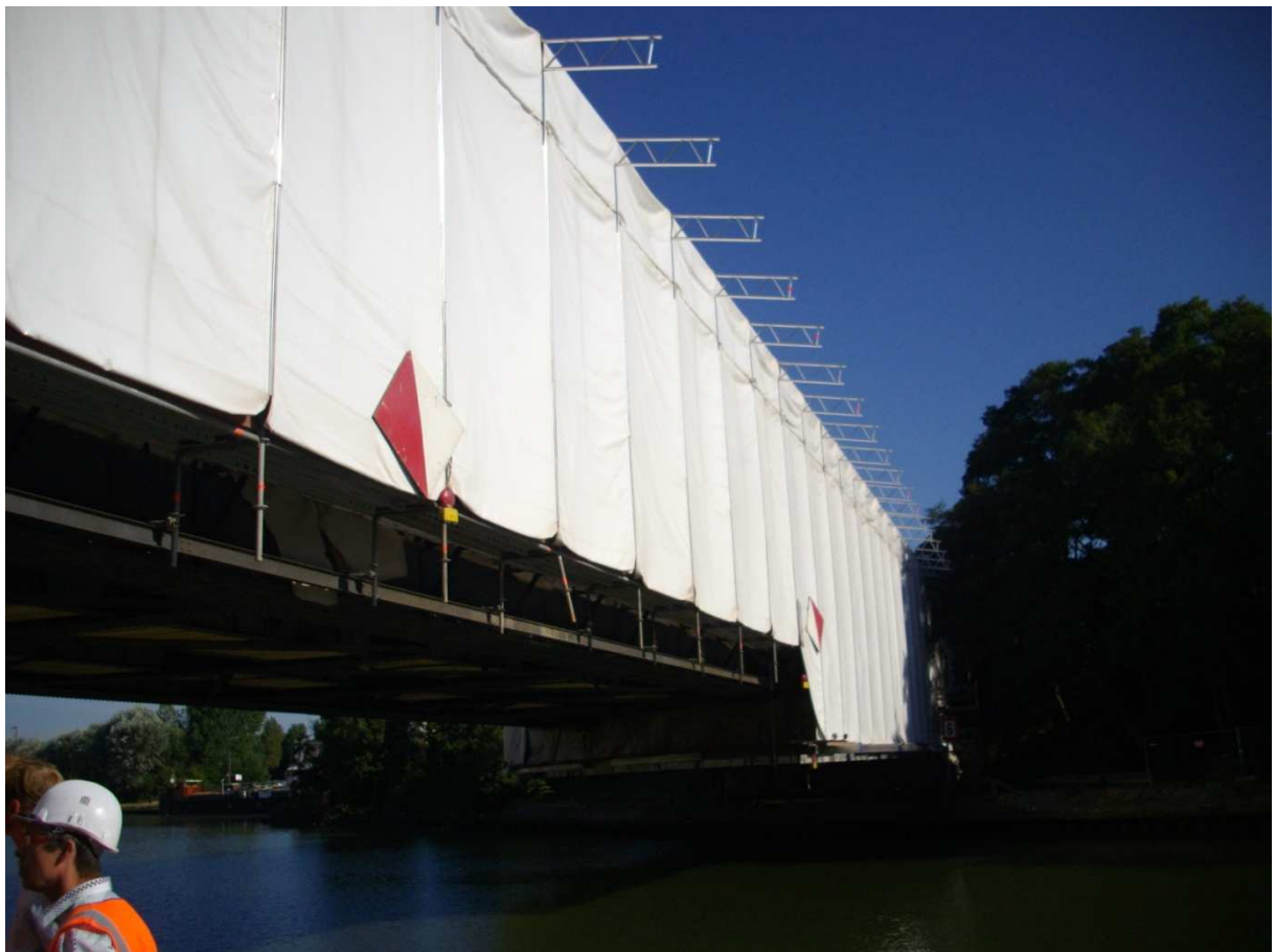
Remise en peinture du pont rail – protection de l'ouvrage
