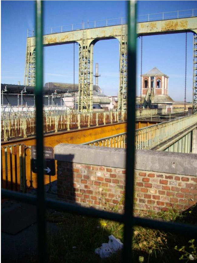
Vue de l'ascenseur à bateaux avant restauration
